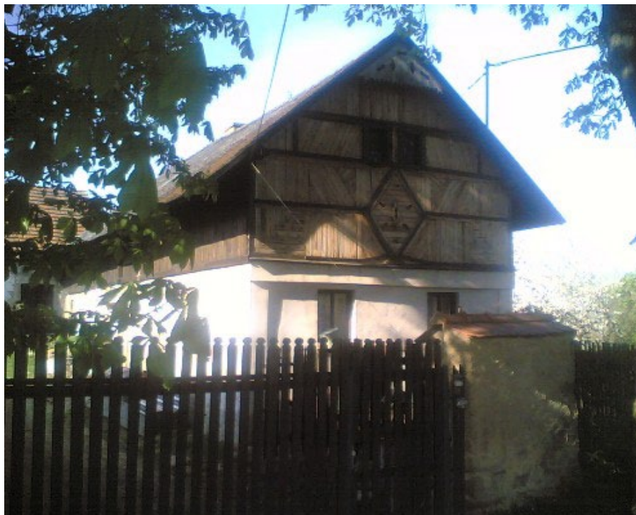
Jeden z domů v obci Klečetné
